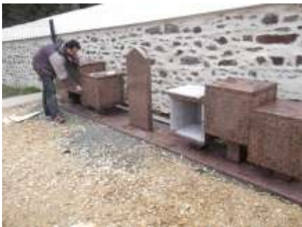
Le columbarium en cours de pose
